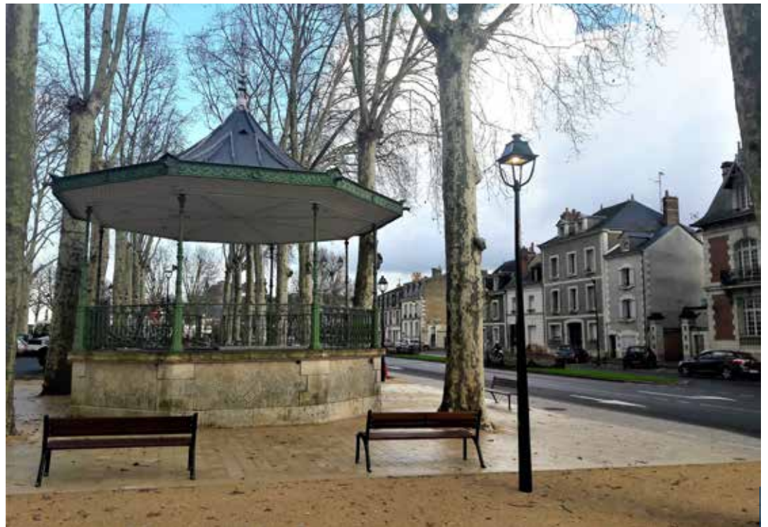
Aux abords du parking et du kiosque, les lanternes 4 faces ont été positionnées sur des mâts de 4 m de haut. En regardant de plus près, les faces des lanternes ne sont pas vitrées, ce qui permet d'optimiser la photométrie. La source Led, installée en sous-face dans le corps de la lanterne, est protégée d'éventuels chocs.
